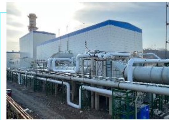
LIAONING BENSTEEL PROJECT
